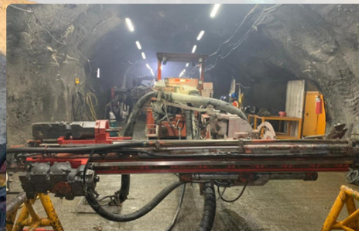
PUESTA EN MARCHA DE EQUIPOS DE SOSTENIMIENTO
