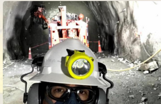
SEGUIMIENTO DE EQUIPOS DE PERFORACIÓN EN TUNEL
