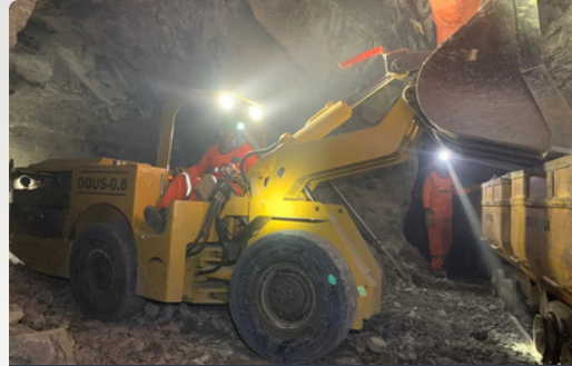
PUESTA EN MARCHA DE EQUIPOS DE ACARREO - SCOOPTRAM
