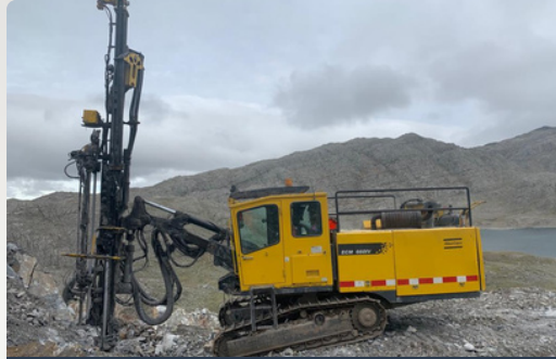
SEGUIMIENTO EN CAMPO DE PERFORADORAS
