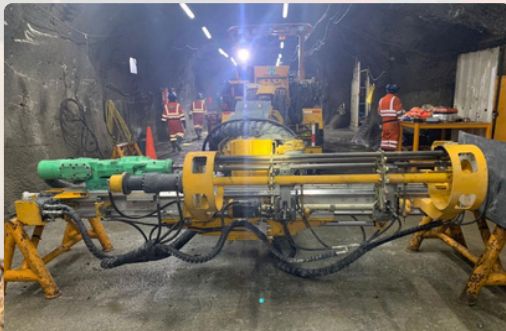
PUESTA EN MARCHA DE EQUIPOS DE TALADRO LARGO
